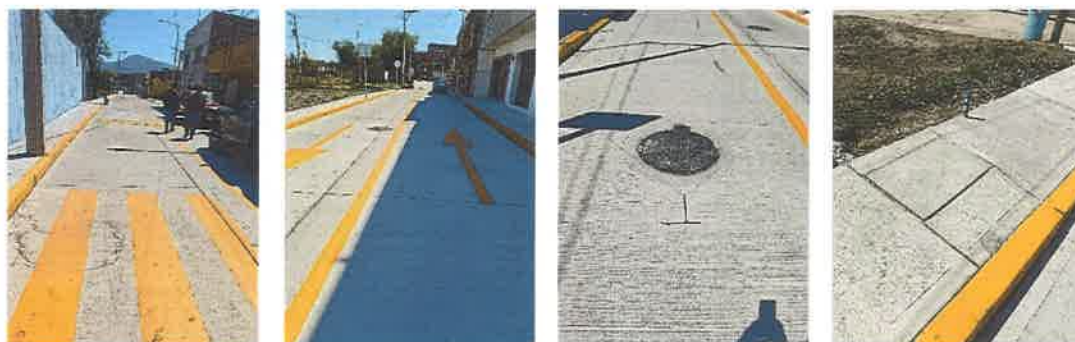
Fotografía 7. Supervisión Entrega-Recepción Pavimentación Calle Mina, Yuriria.
