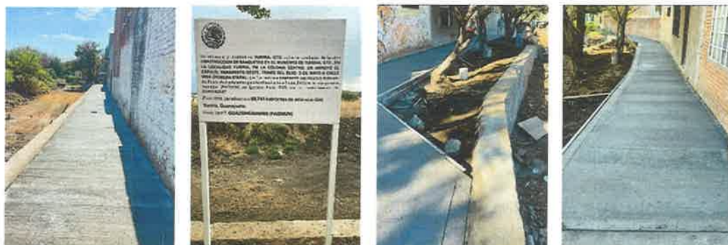
Fotografía 17. Supervisión Entrega-Recepción Construcción de Banquetas en Arroyo El Capulín, Yuriria.
