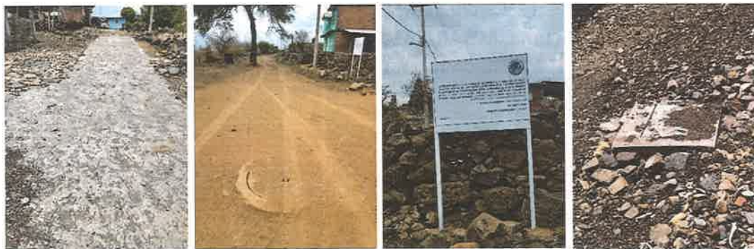
Fotografía 16. Entrega-Recepción Drenaje Calle Juan Pablo I, El Canario.
