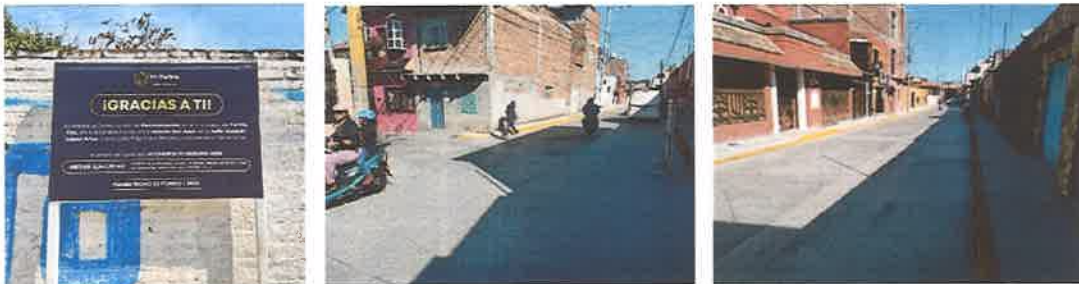
Fotografía 15. Supervisión Entrega-Recepción Pavimentación Calle Joaquín López Arias, Yuriria.
