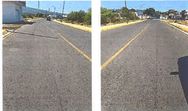
Fotografía 8. Supervisión Entrega-Recepción Rehabilitación Asfáltica, Boulevard Bicentenario, Yuriria.
