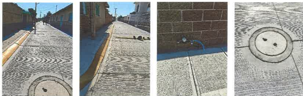
Fotografía 2. Supervisión Entrega-Recepción Calle Reforma, Puerto de Águila.
