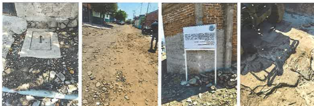
Fotografía 12. Entrega-Recepción Drenaje Calle Fco. Villa, La Calera.
