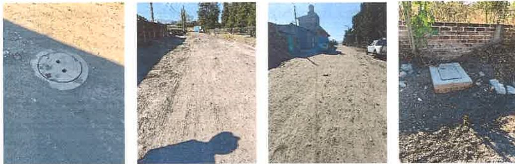
Fotografía 5. Supervisión Entrega-Recepción Drenaje, Casacuarán.
