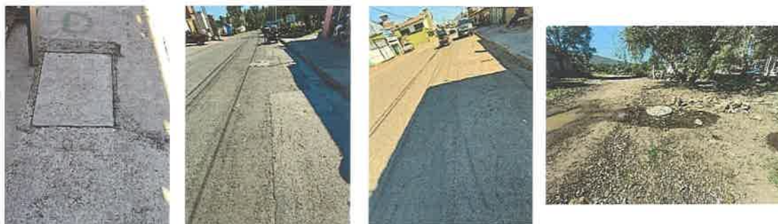
Fotografía 3. Supervisión Entrega-Recepción Drenaje Calle Ignacio Allende, Cerano.
