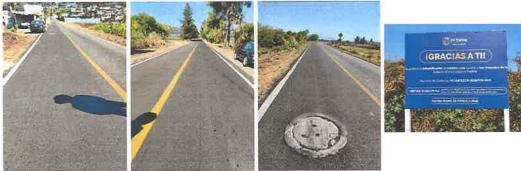
Fotografía 14. Supervisión Entrega-Recepción Rehabilitación Camino Rural Acceso San Francisco de la Cruz.
