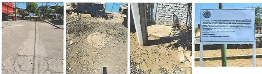
Fotografía 13. Entrega-Recepción Drenaje Calle Ignacio Allende, La Calera.
